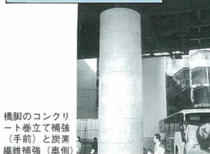
荏田第二高架橋の補強図
