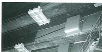
外ケーブルによるPC主桁補強と腹部の炭素繊維による補強
