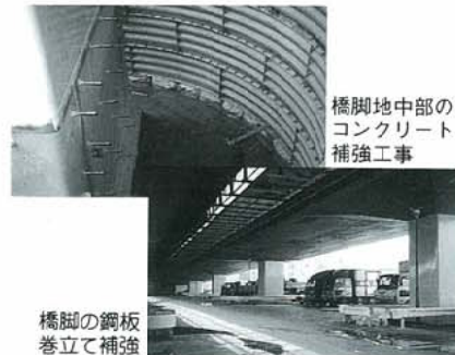
荏田第二高架橋の補強図
