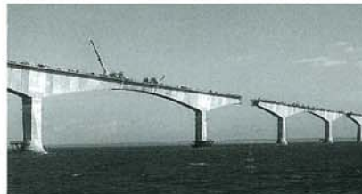
NORTHUMBERLAND 橋の現況
