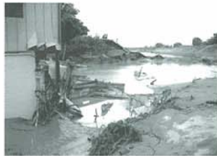
▲刈谷田川左岸 中之島地区破堤箇所 上流側から破堤箇所を写す。
