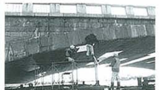
▲写真-4 定期点検
