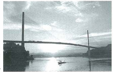
▲写真-3 バイチャイ橋
