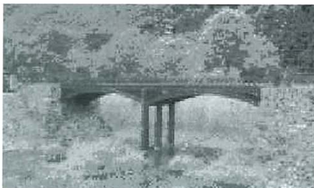
▲写真-2 羽瀨铸铁橋
