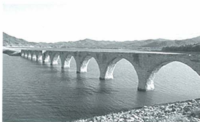
▲写真-1 タウシュベツ川橋梁
