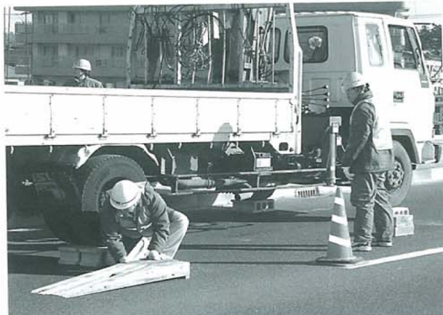
▲写真-1 衝撃振動測定状況
