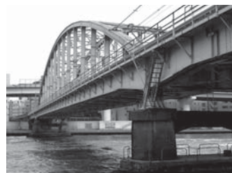
▲写真-5 JR総武線隅田川橋梁
