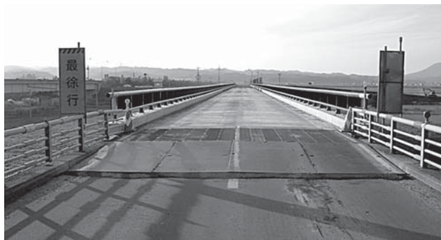
▲写真-2 昼間全面交通開放状況
