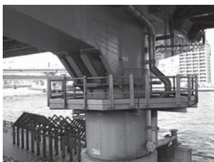
▲写真-2 鋼製丸橋脚隅角部補強
