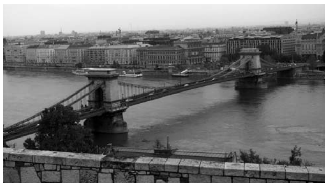
▲写真-2 セーチェニ鎖橋
