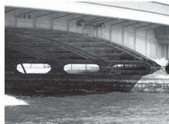
▲写真-4 両国橋橋台
