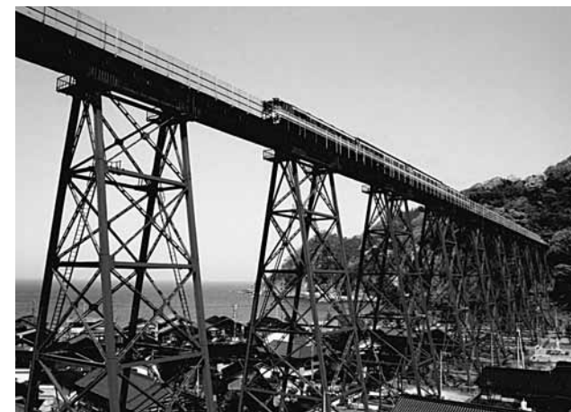
▲写真-2 余部鉄橋全景
