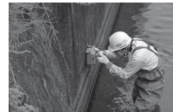
▲写真-3 電磁波レーダー法測定状況
