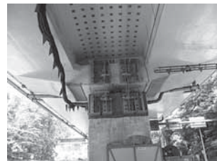
▲写真-5 施工完了箇所
