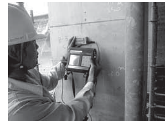
▲写真-2 電磁誘導法測定状況
