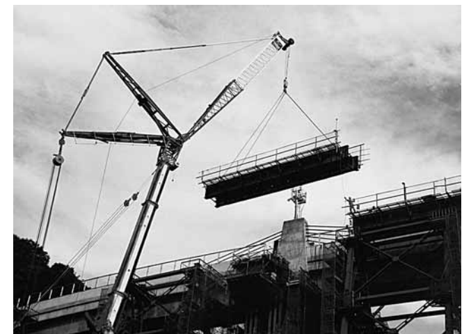
▲写真-5 解体される余部鉄橋
