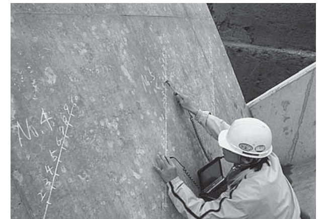
▲写真-4 衝撃弾性波法(iTECS法)測定状況
