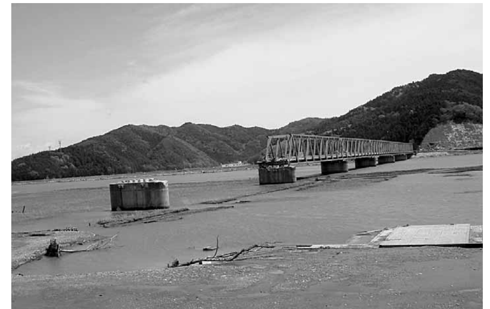
▲津波で上部工が2箇所流失した橋梁
