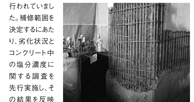
▲写真-3 ウォータージェットによるはつり状
