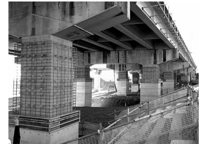
▲写真-2 コンクリート巻立(鉄筋配置)
