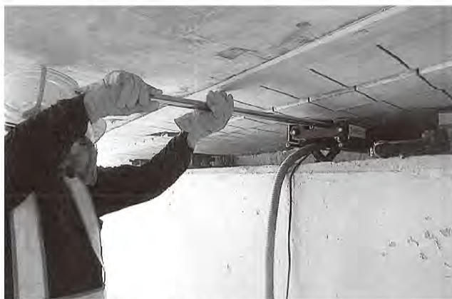
橋梁桁端部の電気防食工法(GECS工法)陽極設置状況
