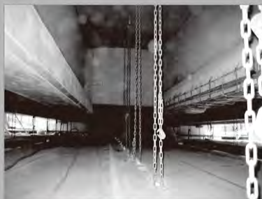
▲ 断面修復工事
