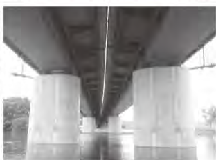
PC コンファインド工法 (橋脚の耐震補強工法)
