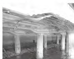
PI-Slit 工法 (線状陽極方式電気防食工法)
