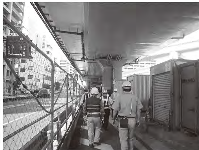
写真-2 吊り足場内への入場
