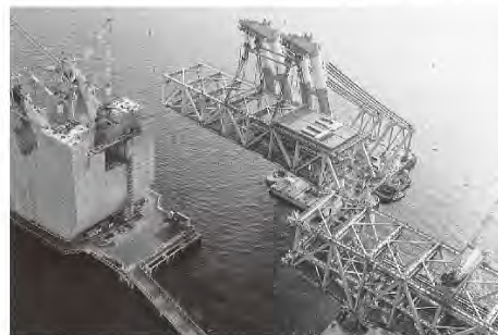
写真-2 第二ブロック一括架設
