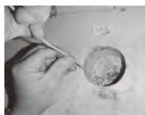
リパッシブ工法 (PC グラウト充てん不足部補修工法)
