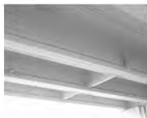
PI-Slit 工法 (線状陽極方式電気防食工法)
