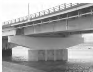
PC コンファインド工法 (橋脚の耐震補強工法)
