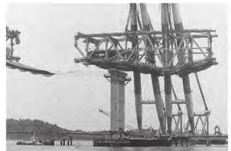
写真-1 第一ブロック一括架設
