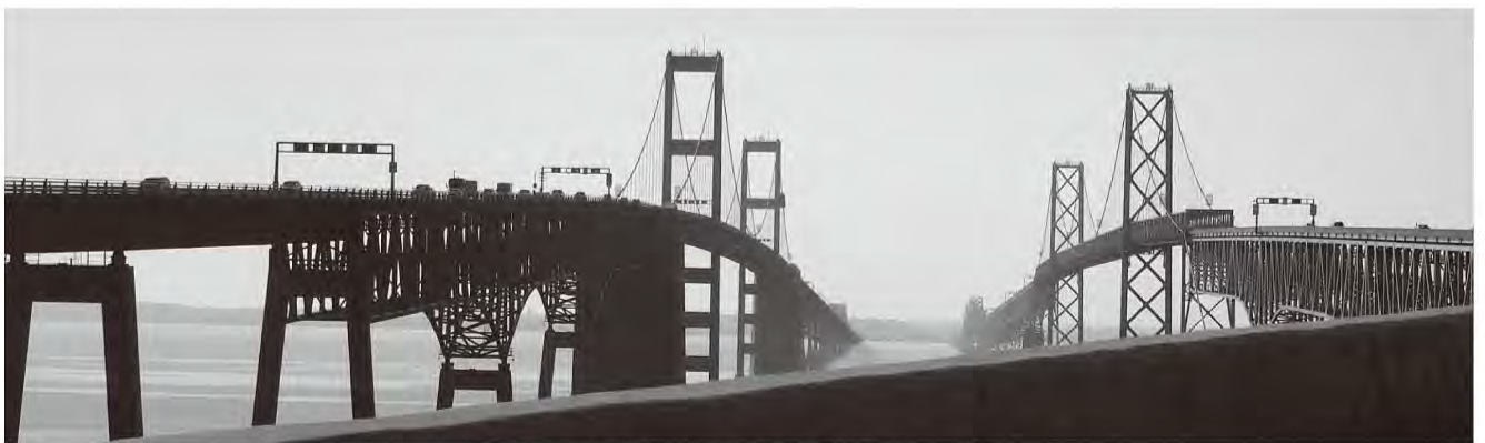
写真-2 西側アプローチ橋 橋面より (左:新橋、右:旧橋)
