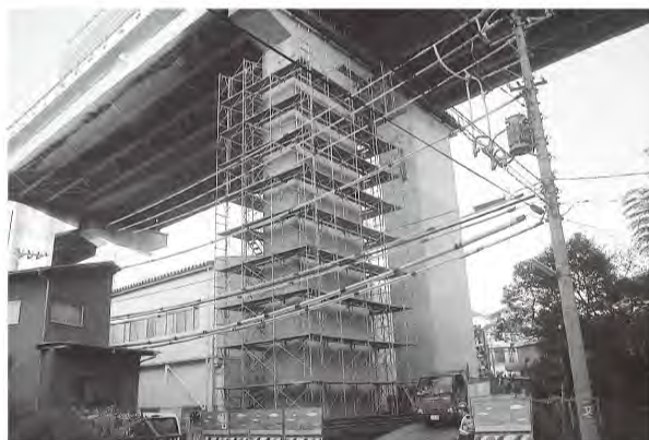
写真-1 市街地での足場架設状況
