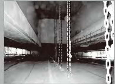
▲ 断面修復工事
