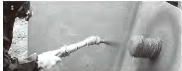
▲TDRショット工法 厚付け状況
