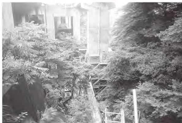
写真-2 山間地での足場架設状況
