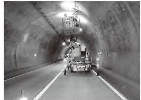
▲トンネル定期点検
