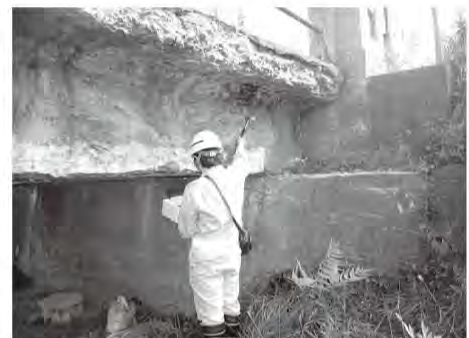
▲既設橋梁の内部診断
