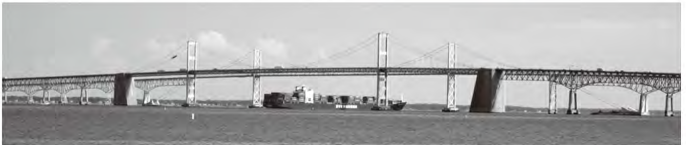
写真-1 吊橋部の全景 (サンディーポイント州立公園より 手前:新橋、奥:旧橋)
