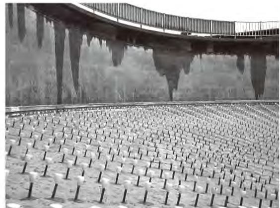
CCb 工法 施工状況
