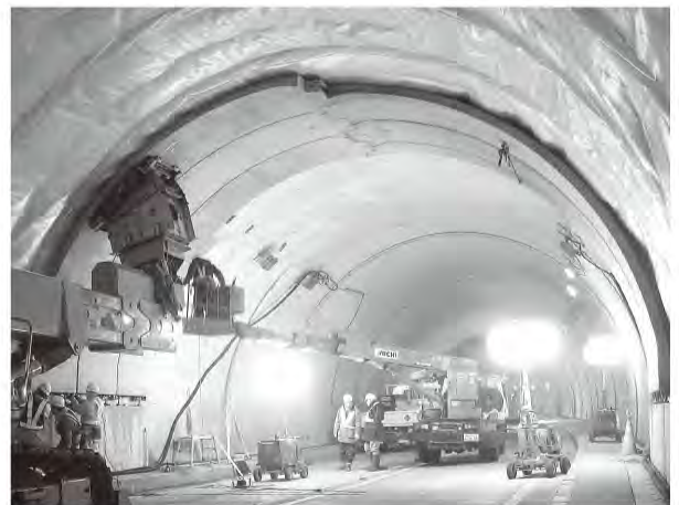
▲ PCL 版を専用機械による据付状況
