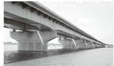
写真-3 PCコンファインド工法
