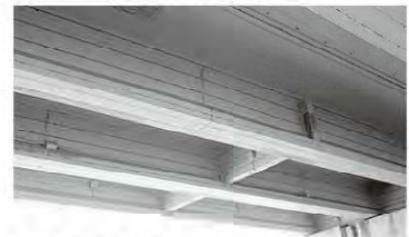
写真-2 PI-Slit工法（ピーアイスリット工法）
