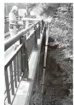
リモートカメラによる橋梁点検
