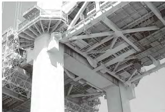
吊橋の耐震補強工事(首都高:レインボーブリッジ)
