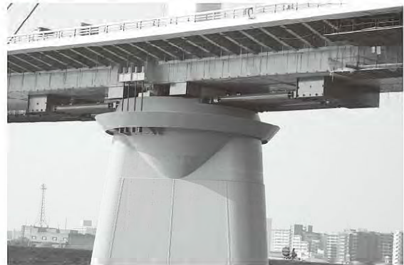
斜張橋の耐震補強工事(首都高:かつしかハーブ橋)
