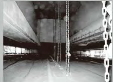
▲ 断面修復工事
