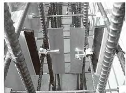
ND-WALL工法 施工状況
