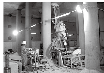
地下配水池内での高耐久マイクロパイル施工状況
