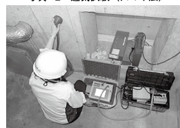
写真-3 内部探査 (超音波トモグラフィー)
