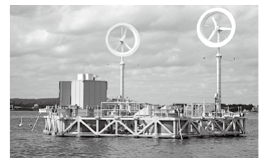
写真-3 洋上風力発電実証実験 コンクリート浮体
