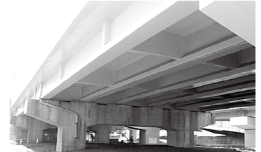
写真-1 小余綾高架橋の補修工事
