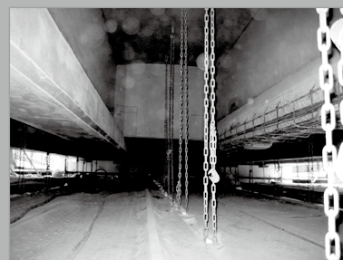
△ 断面修復工事
