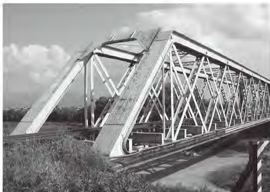
写真-3 錬鉄製ピントラス桁（左沢線最上川橋梁）
