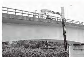
橋梁点検車を用いた橋梁点検の状況
