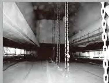
▲ 断面修復工事
