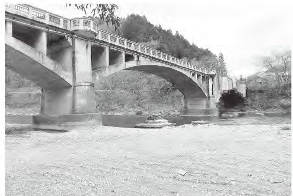
写真-2 バルコニーと2代目橋梁の橋脚基部
