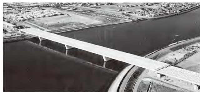
員弁川橋(床版架設後)全景
