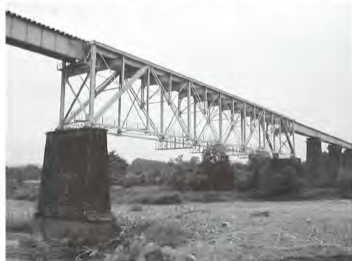
写真-1 磐越西線一ノ戸川橋梁
