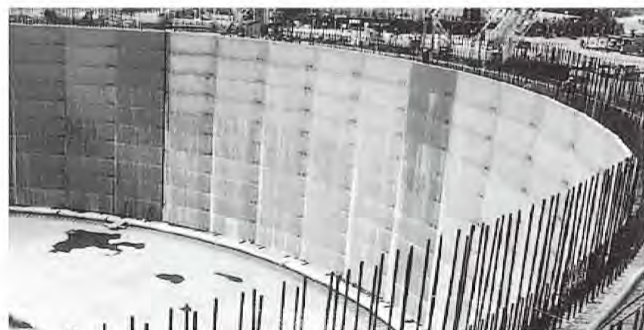
LNG地下式貯槽用セグメント
