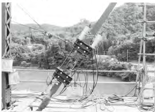
写真-4 アイバー短縮（加熱短縮方法）
