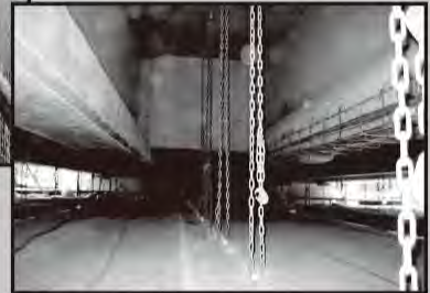
▲断面修復工事
