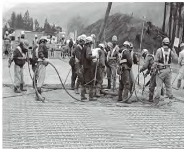
写真-2 向定内橋の施工
