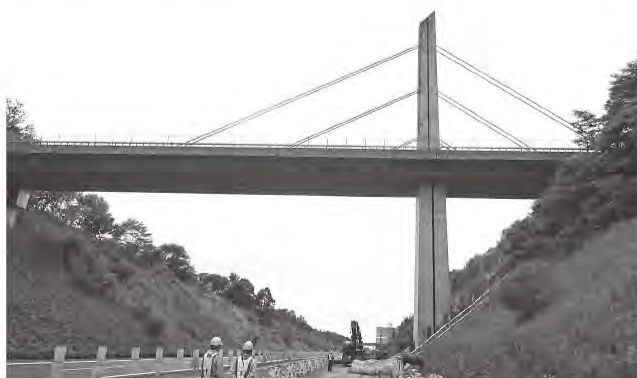
耐震補強実施中の錦岡3号橋
