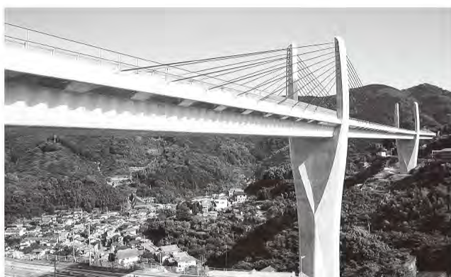
完成した日見夢大橋全景
