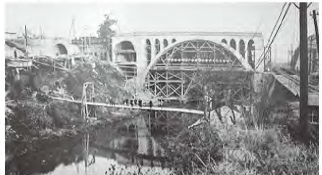
写真-3 架設中(参考文献：土木学会図書館)
