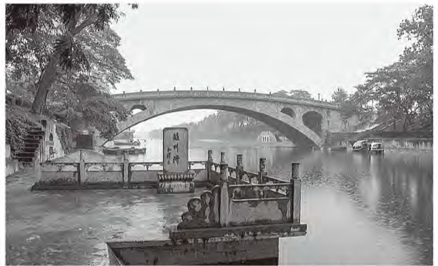
写真-7 現存する最古の石造扁平円形アーチ橋
