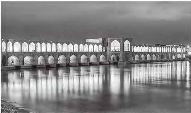
写真-8 ダム機能を持つ石造アーチ橋・ハージュ橋
