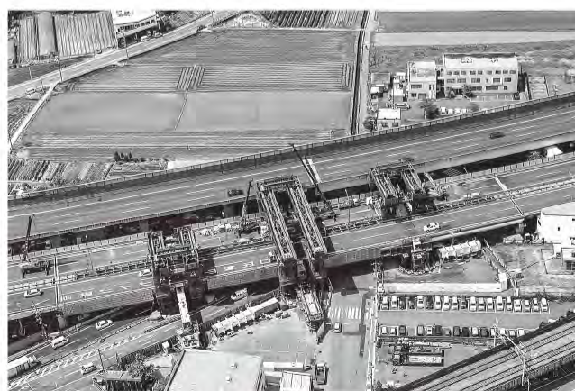
下植野高架橋 横梁取替え工事中
