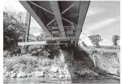
橋梁点検車による点検状況
