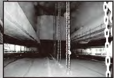
▲断面修復工事
