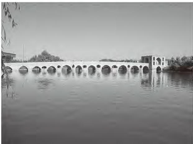
写真-6 イランの13径間石造円形アーチ橋
