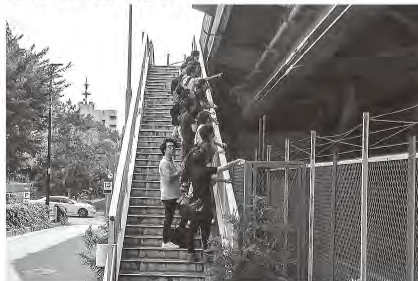
【鋼橋の補修・補強】
