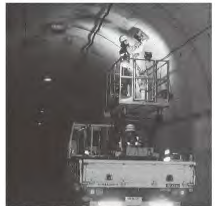
レーダ探査による覆工背面空洞探査状況
