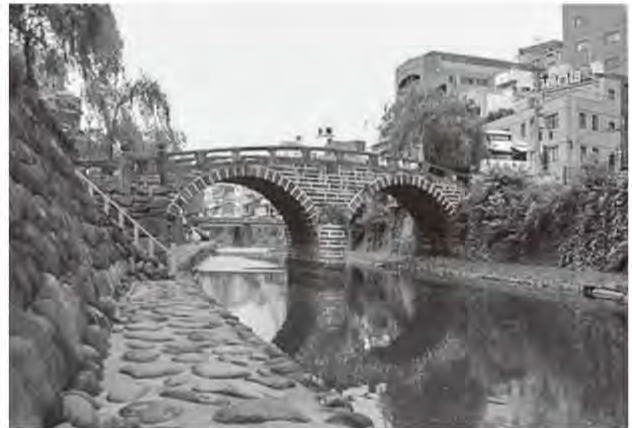
写真-9 日本で最初の石造アーチ橋・長崎眼鏡橋
