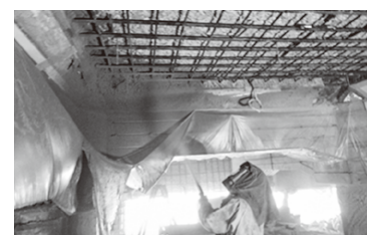
乾式吹付け工法「リフレドライショット工法」(NETIS:KK-110042-A)
