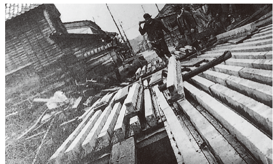
写真-2 長生橋の架設風景
