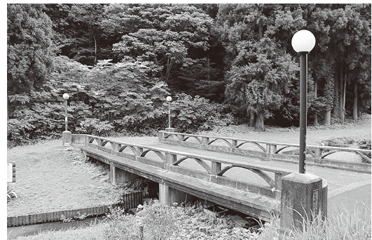
写真-3 移設・復元された長生橋の全景(2019年9月撮影)
