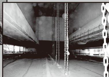
▲断面修復工事
