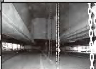
▲断面修復工事
