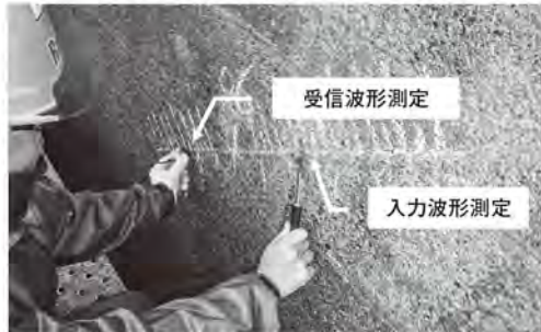
図-3 コンクリートの弾性波計測状況
