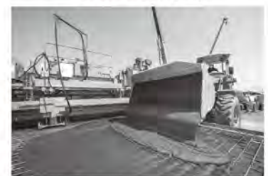
UHPFRCの打込み
