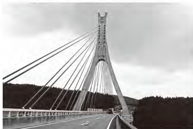
建設後20年経過当時の碓氷橋
