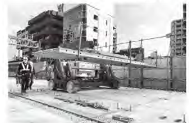
平板型UFC床版の架設
