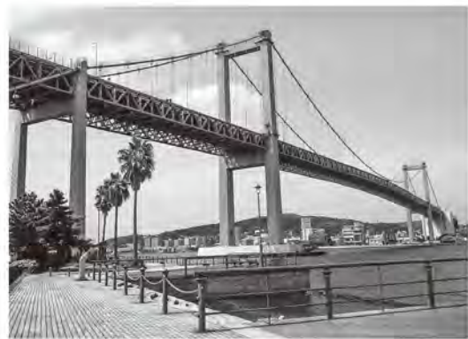
写真-1 若戸大橋（戸畑側より）
