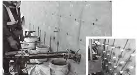
セラミックキャップバー工法
