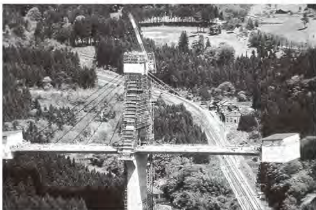
建設中の碓氷橋
