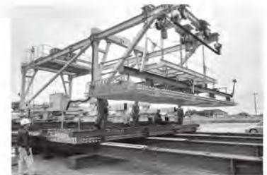
SDRシステムによる床版の架設
