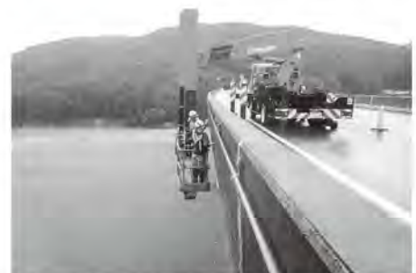
橋梁点検作業(点検車)
