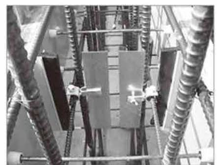
ND-WALL工法 施工状況
