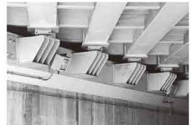
写真-2 横変位拘束構造・水平力分担構造
