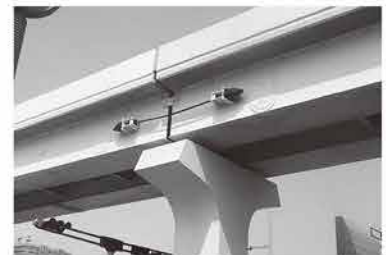
写真-1 落橋防止装置
