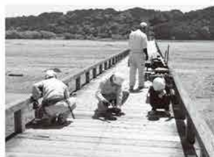
写真-3 補修状況
