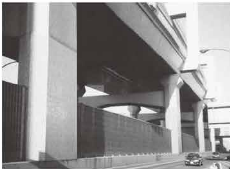
写真-1 アラミド繊維シートによる橋脚の補強例
