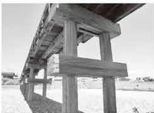
写真-2 橋脚の状況
