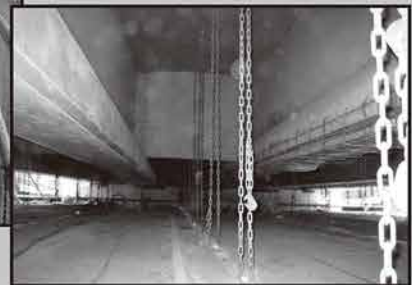
▲断面修復工事
