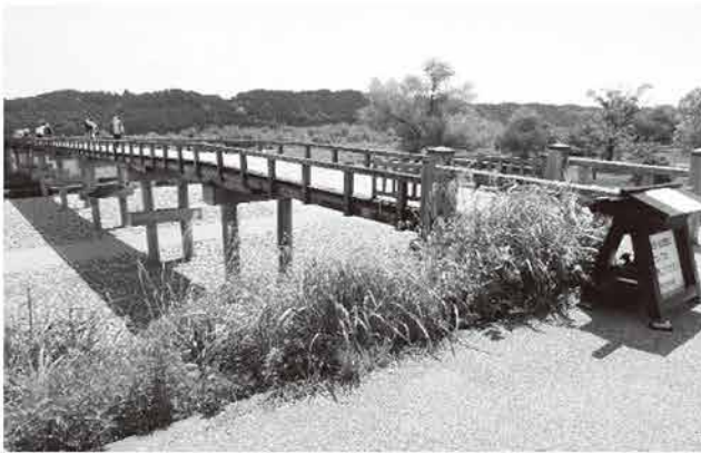
写真-1 全景(左岸より)
