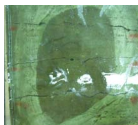
NAV工法施工後
