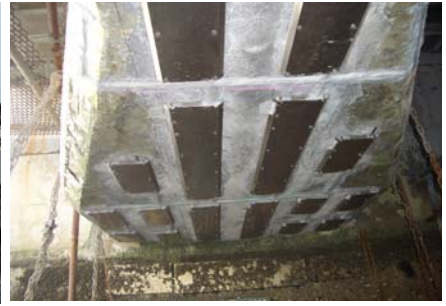
写真2 チタントレイ方式 栈橋の梁下面（銀色）
