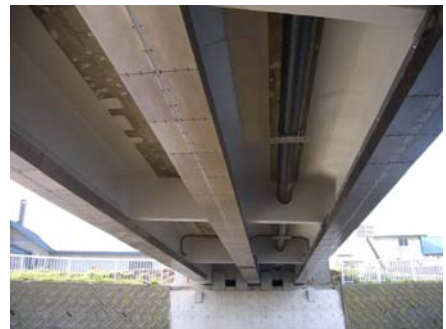
写真5 チタントレイ方式 道路橋のPC桁（銀色）
