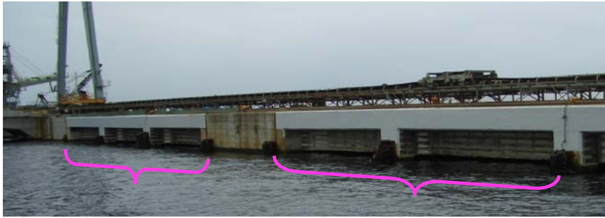
写真1 チタントレイ方式 栈橋の梁側面（銀色）
