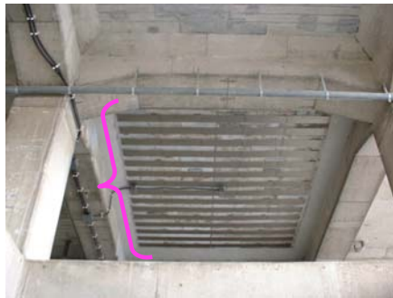
写真4 チタントレイ方式 鉄道橋の床版（銀色）
