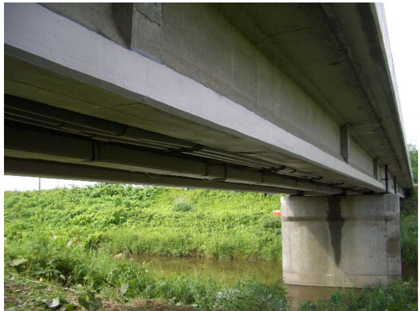
写真7 キャブロンコート方式 道路橋のPC桁、下フランジ部（白色）
