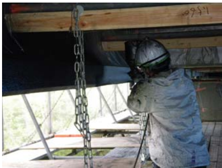
写真6 キャブロンコート方式 導電性塗料の塗布状況（黒色）
