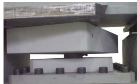
写真 2 破断時の状況
