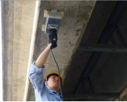
写真下 測定状況 (PC 桁)
