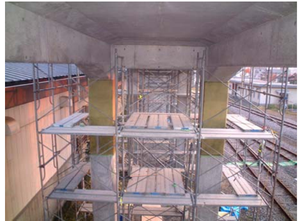
■ 鉄道高架橋耐震補強
