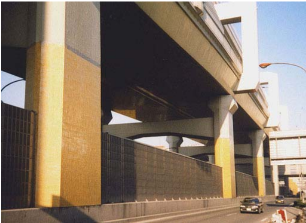
■ 高速道路橋脚耐震補強
