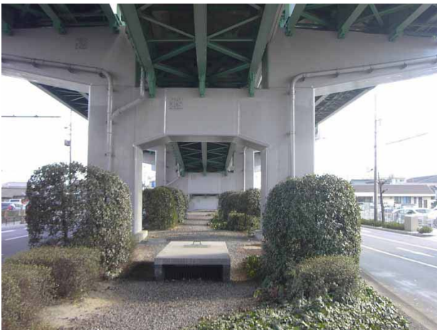
■ 高速道路橋脚横梁耐震補強
