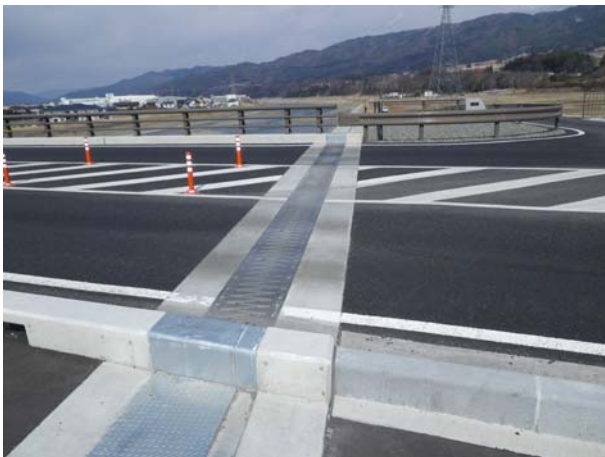
KMA ジョイント設置状況
