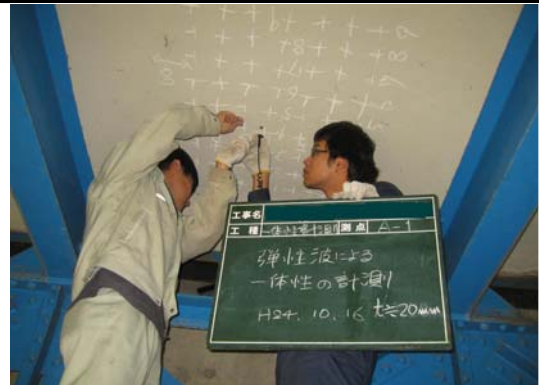
図1 PCMにより補強した床版下面での測定状況
