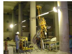
(d) 配水池内施工状況
