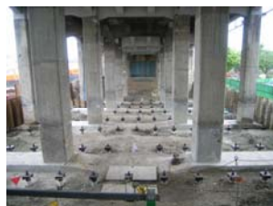
(c) HMP 施工完了状況
