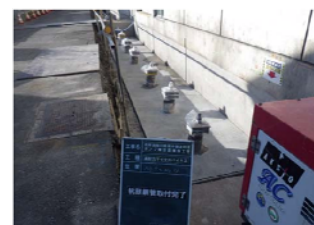
(c) HMP 施工完了状況
