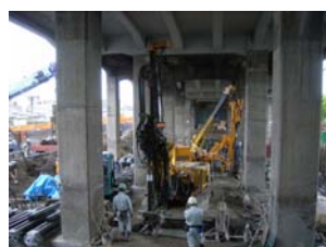
(a) 施工状況
