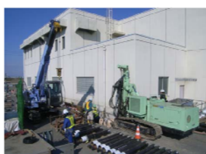
(b) 施工状況
