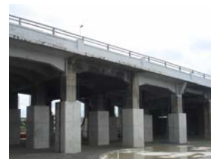
(d) 補強工事完了状況
