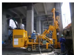
(b) 施工状況
