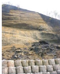
モルタル吹付け法面の崩壊
