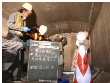
【橋梁下面からの施工】
