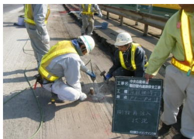
【切断面からの施工】
