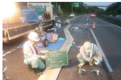
【舗装面からの施工】
