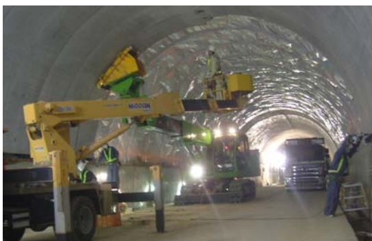
スピナーームによる架設状況
