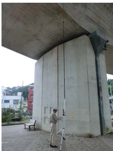
支承部の点検
