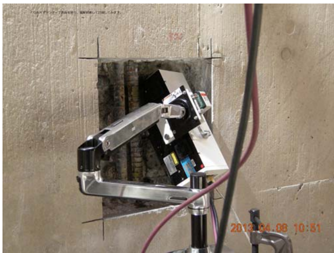
コンクリートをはつり鉄筋表面を測定
