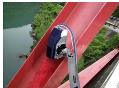
トラス橋斜材の測定
