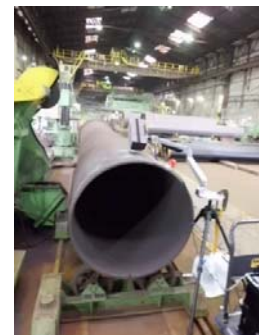
配管溶接部の測定
