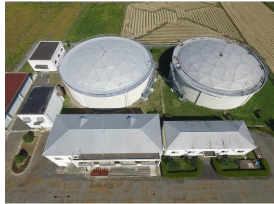
ドーム屋根への架替事例 2 (2池ともアルミドームに架替)
