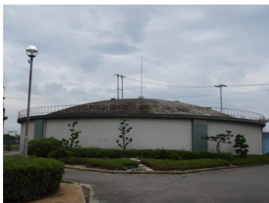
ドーム屋根への架替事例 1
