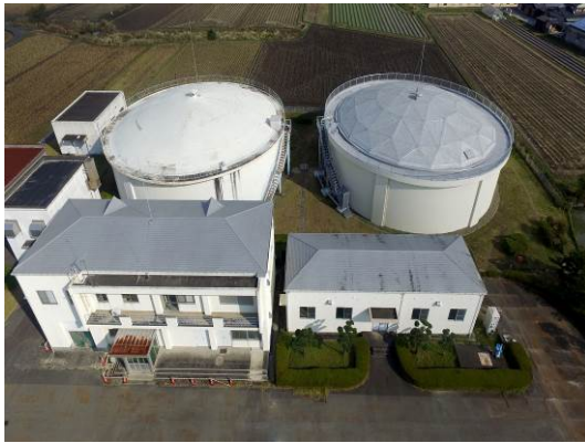
ドーム屋根への架替事例 2 (2池ともアルミドームに架替)
