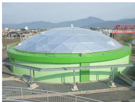
ドーム屋根への架替事例 1
