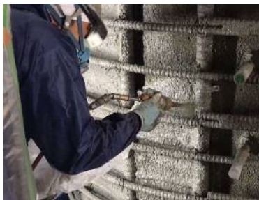
湿式吹付施工
