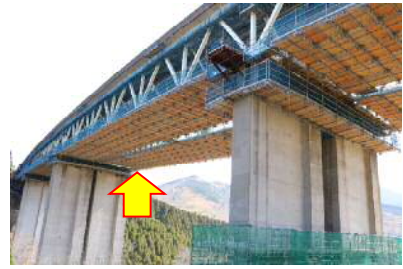
写真一 1 橋梁での使用例
