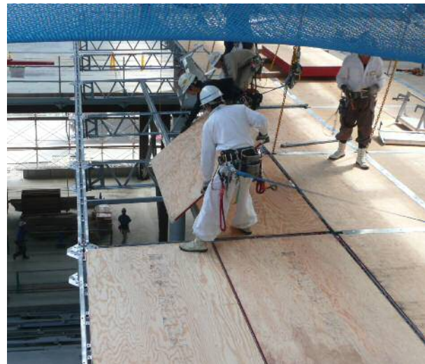
写真一 4 先行床施工
