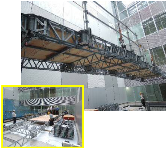
写真一 3 ユニット一括吊上げの様子
