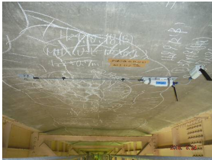
IoT センサを道路橋床版下面に設置した事例
